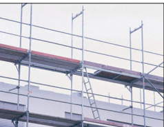
Arbeiten mit Gerüsten
