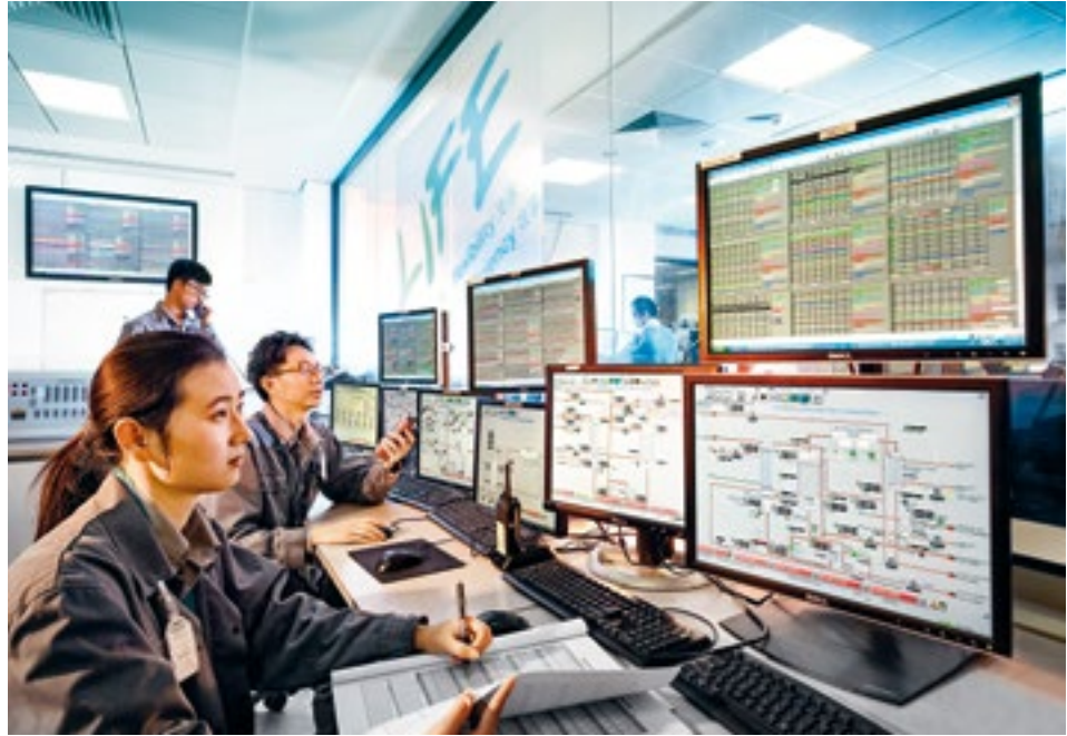
Der Kontrollraum der MDI-Anlage in Caojing, Shanghai: Die Bayer-Mitarbeiterin Fanny Fan (vorn) und ihre Kollegen Todd Huang (Mitte) und Qi Wu nutzen das Managementsystem STRUCTese™, um den Energieverbrauch der Anlage zu senken.
