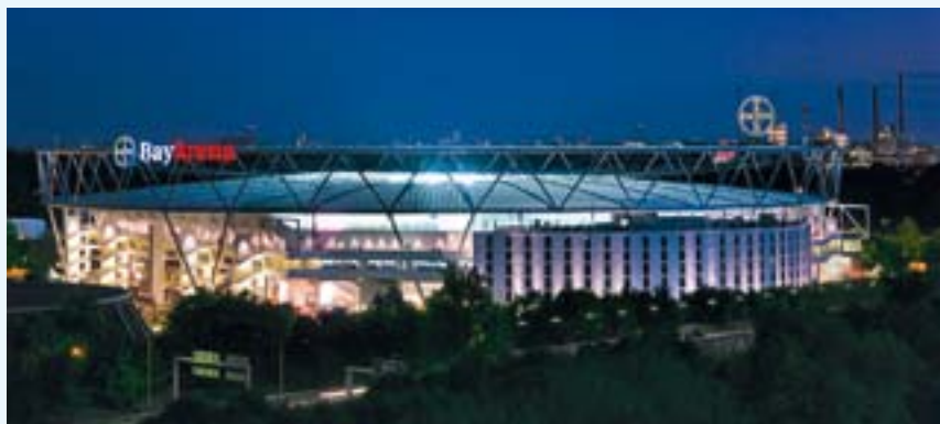
Beeindruckend auch bei Nacht: das Dach der neuen BayArena mit Platten aus Makrolon®.
