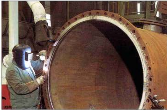
Druckbehälter-Reparatur: Anschweißen einer Nickel-Drahtleiste.
